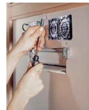
2. Halteleisten befestigen. Bei Metall-Türseitenteilen können die Dichtgummis problemlos eingezogen werden. Danach erfolgt die Verkabelung der Sprech-Klingelanlage.
