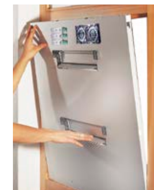
1. Nachdem die Kastenblöcke von der Frontplatte getrennt wurden, kann diese auf einfache Art und Weise in das Türseitenteil eingesetzt und ausgerichtet werden.
