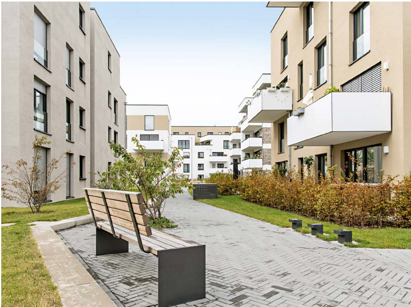
Wie modern ein Wohnensemble ist, zeigt sich auch an den gebotenen Dienstleistungen. Die Bewohner der 92 GBG-Wohnungen im Main-Kinzig-Quartier können unter anderem auf digitale Services zurückgreifen
