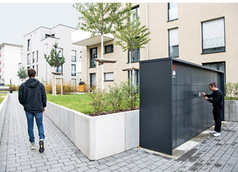
Die Paketbox-Anlage ist über eigens entwickelte offene Schnittstellen mit der Türkommunikation verknüpft. Per App können Mieter auf beide Funktionen zugreifen
